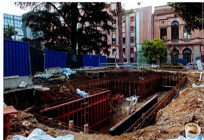
Sopra: la ricostruzione della struttura della platea e degli ambienti sottostanti; la torre scenica riammodernata con il nuovo sipario tagliafuoco; sotto: le operazioni di restauro dei fregi e delle superfici decorate interne della sala; la nuova vasca di accumulo dell'impianto automatico di spegnimento incendi; nella pagina seguente: la prima galleria dopo gli interventi di ristrutturazione e restauro.
