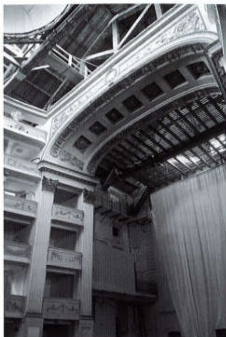
Fig. 1. Vista della copertura prima del restauro, da cui si scorge la cupola apribile realizzata negli anni Trenta.
