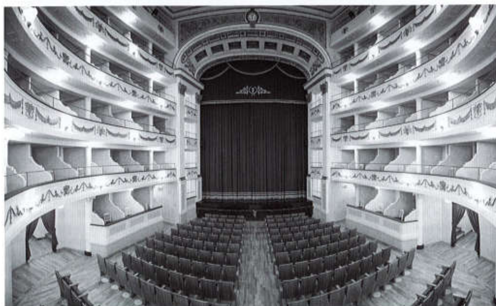
Fig. 17. Vista dell'interno dopo il restauro.
