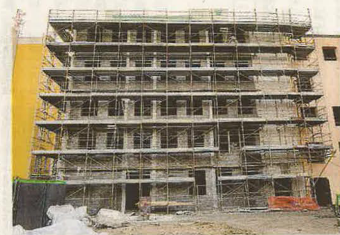
Il lato uffici del teatro, anche qui lavori in corso
