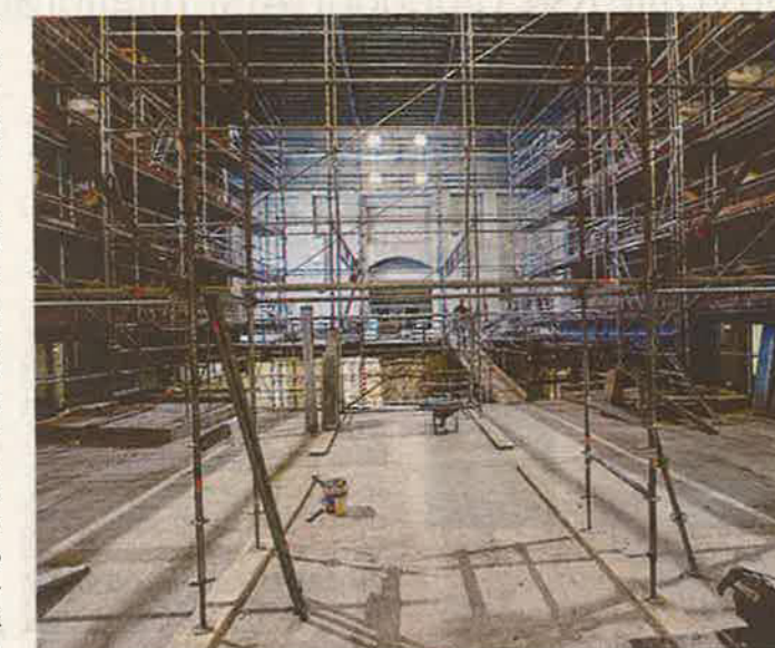
Ponteggi in platea per il restauro del soffitto FOTO GIANFRANCO ROTA
