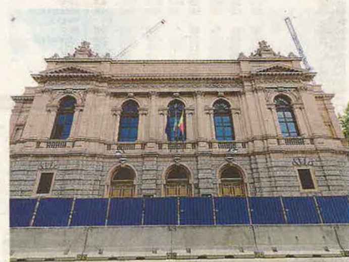
Si allungano i tempi per i lavori di ristrutturazione del Donizetti
