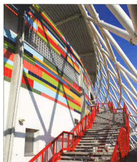
In questa pagina, il sistema strutturale aggiunto all'esterno del preesistente edificio. In alto, schemi assonometrici dei corpi scala e dell'intera gabbia reticolare in tubi di acciaio. In basso, dettagli: da sinistra, nodi della maglia e ancoraggio al piede, il reticolato all'altezza del primo livello, e uno dei
