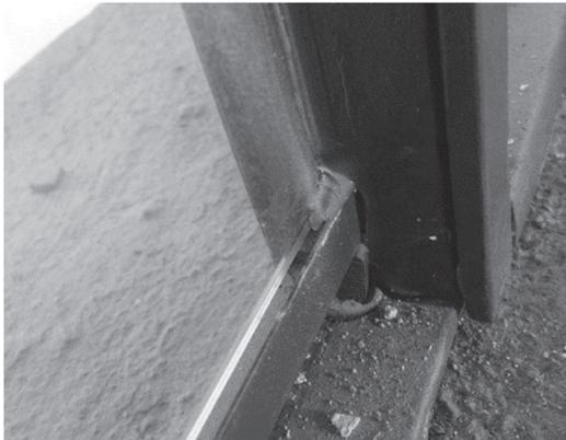
Figura 7 – fessura per microventilazione
