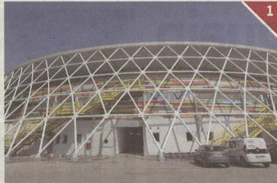
IL CESTO ROVESCIATO. La difficoltà della rete di tubolari esterna è stata quella di circondare la vecchia struttura arrivando a chiudere in cerchio combaciando perfettamente. È un cesto rovesciato.
