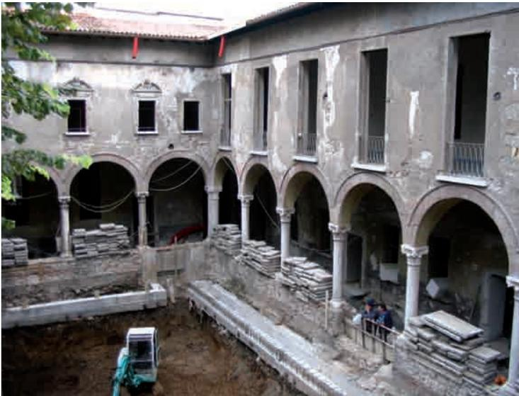
FIGURA 14 • Brescia, Complesso dei Chiostri del Carmine. Lavori di scavo nel cortile del chiostro maggiore per la realizzazione del grande deposito librario interrato.
