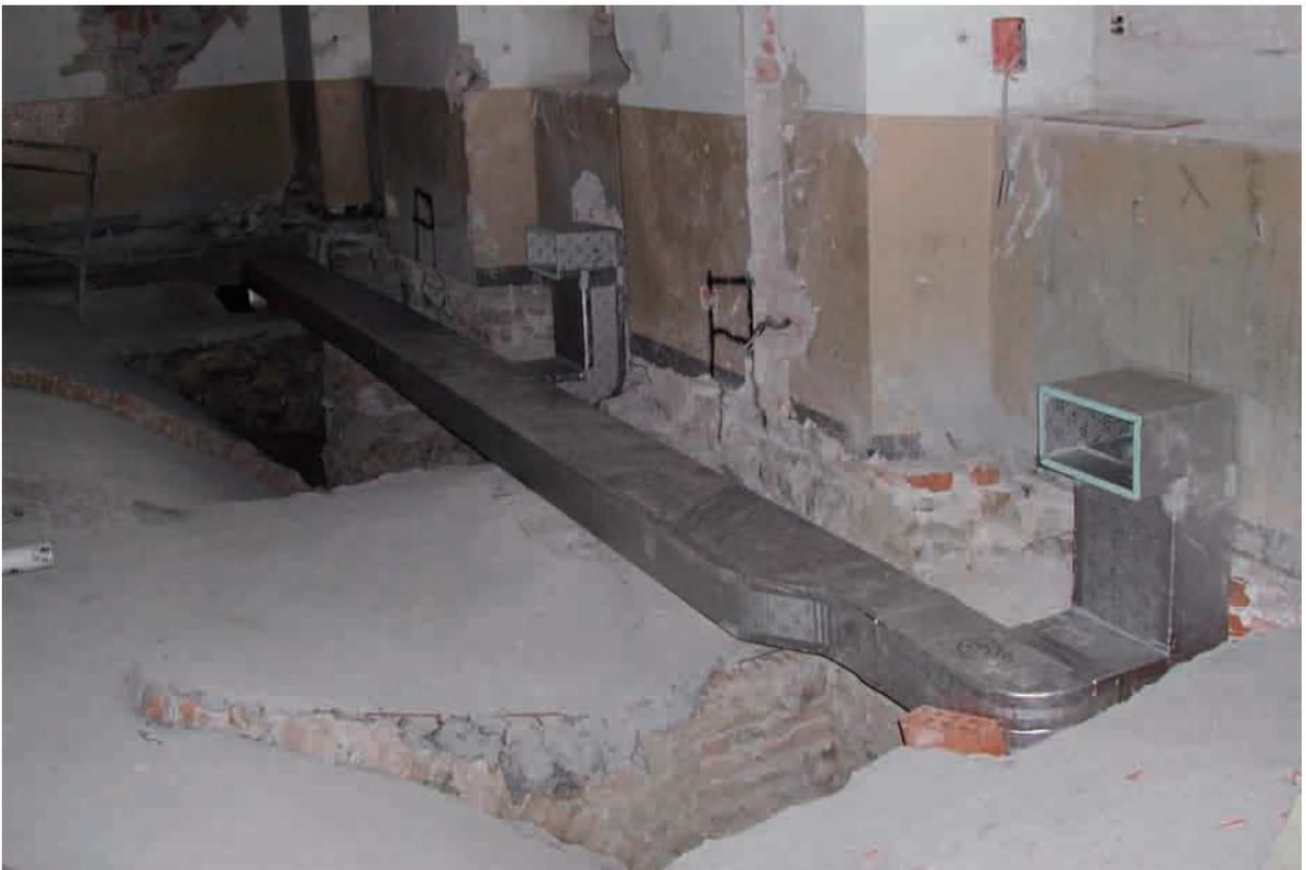
FIGURA 43 • Brescia, Complesso dei Chiostri del Carmine. Particolare dell'inserimento dei canali di climatizzazione realizzato sfruttando i rinfianchi delle volte a botte ma rispettando i frenelli.
