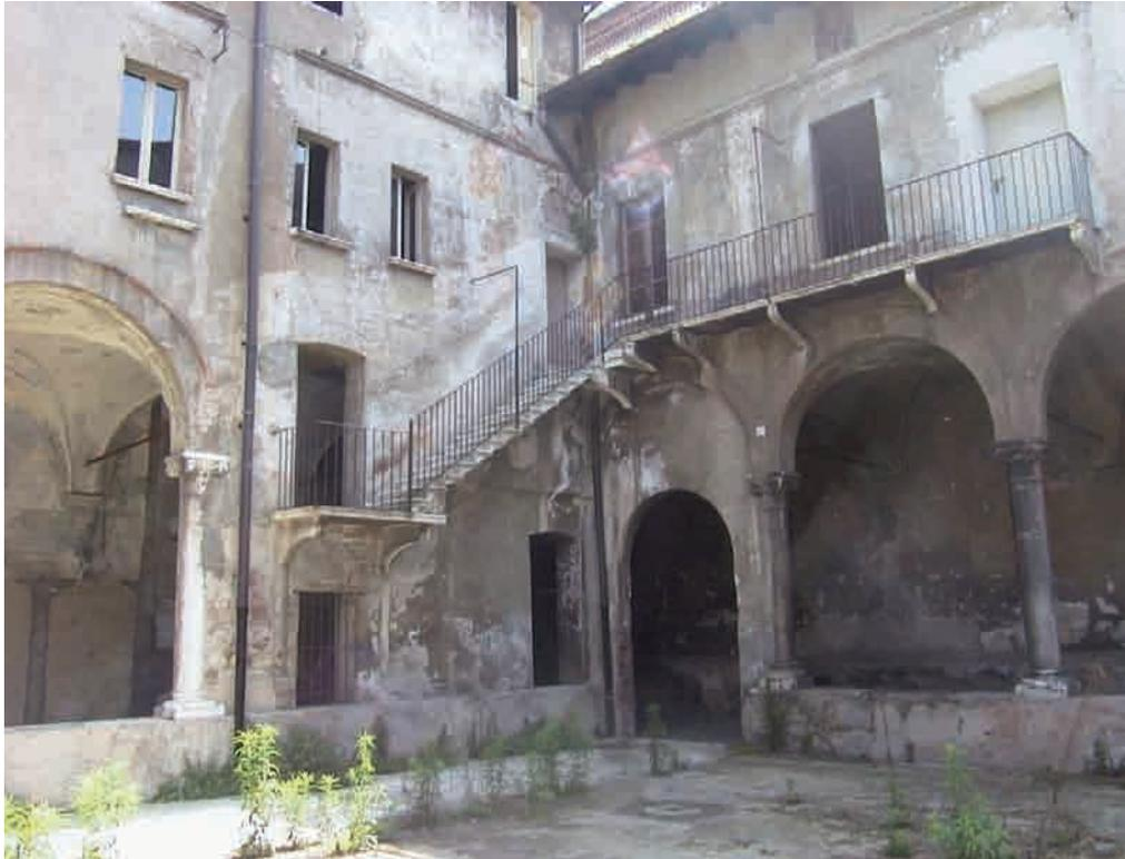
FIGURA 3 • Brescia, Complesso dei Chiostri del Carmine. L'angolo nord-est del chiostro meridionale prima degli interventi di restauro con, in evidenza, la scala aggiunta in epoca successiva mediante tamponatura di un'arcata.
