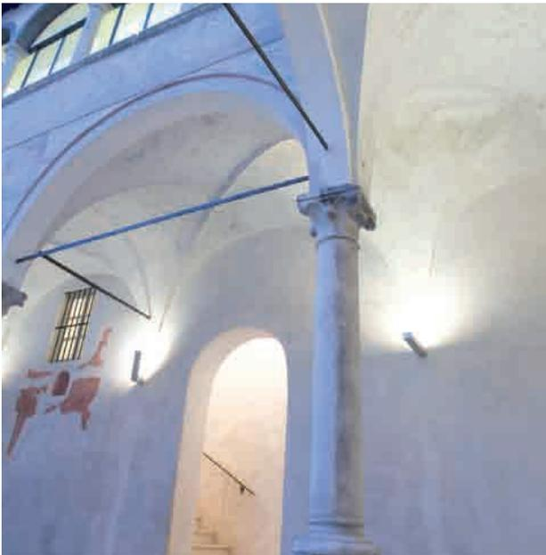
FIGURA 28 • Brescia, Complesso dei Chiostri del Carmine. Particolare del restauro conservativo degli intonaci mediante integrazione delle lacune con materiali similari.
