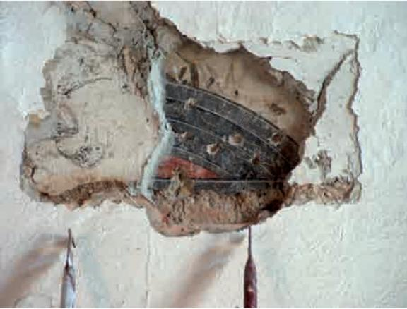
FIGURA 44 • Brescia, Complesso dei Chiostri del Carmine. Galleria dei Novizi, parete di accesso alle celle: dettaglio di un saggio stratigrafico.
