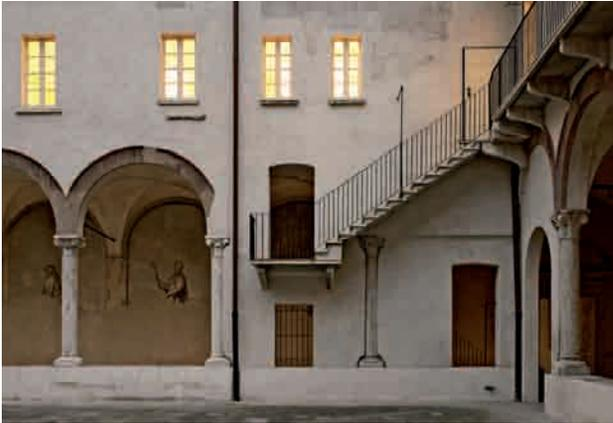
FIGURA 27 • Brescia, Complesso dei Chiostri del Carmine. Chiostro meridionale: opere di restauro concluse con, in evidenza, il rinvenimento della colonna dell'arco originale tamponato.
