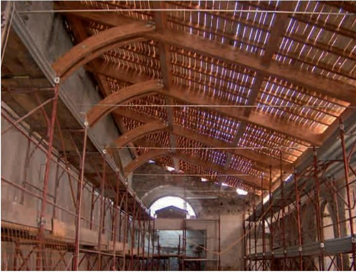
FIGURA 13 • Brescia, Complesso dei Chiostri del Carmine. La nuova struttura di copertura del corpo principale prima della ricostruzione della Galleria dei Novizi modificata, ai primi del '900, ad uso di aule scolastiche.
