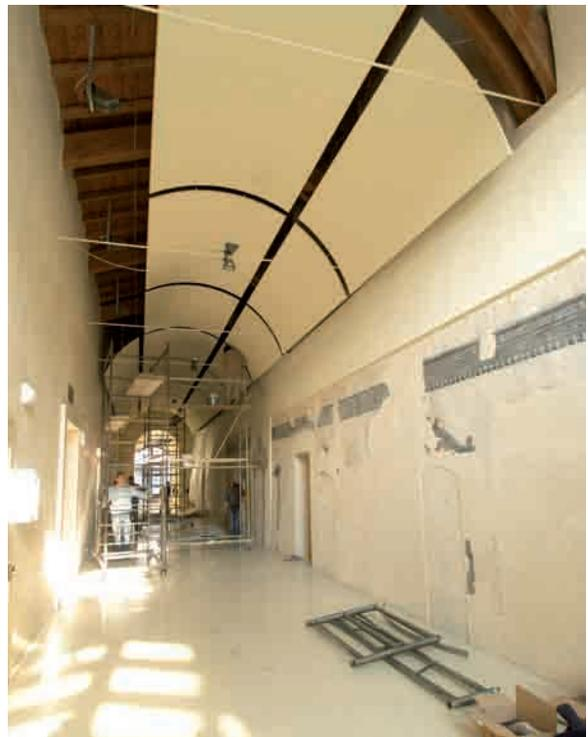
FIGURA 20 • Brescia, Complesso dei Chiostri del Carmine. Galleria dei Novizi: la realizzazione finale con la volta in pannelli modulari lignei indipendenti fra loro.
